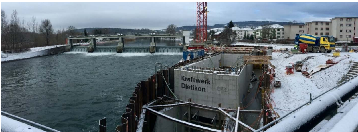
Vue d'ensemble du chantier de l'usine de dotation et du barrage sur la Limmat
