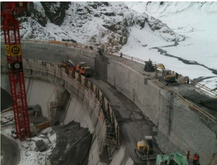
Démolition de la partie supérieure du premier barrage (2012)
